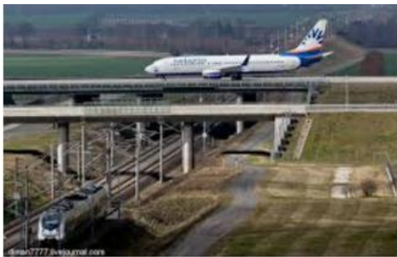
Рис. 1. Динамічне навантаження шляхопроводів літаками
