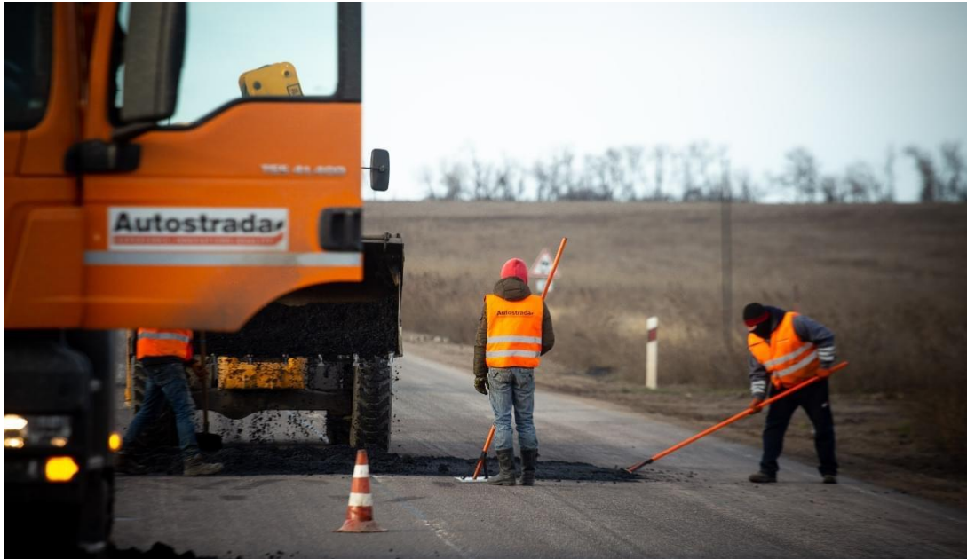
Рисунок 4 – Укладання та розрівнювання суміші вручну
