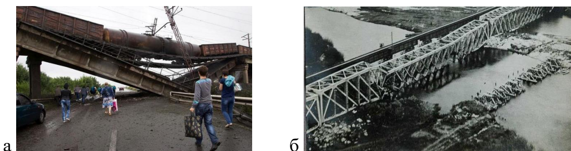
Рисунок 3 – Повністю зруйнований міст, прогонові будови якого придатні для використання при відновленні (а, б) [2]
