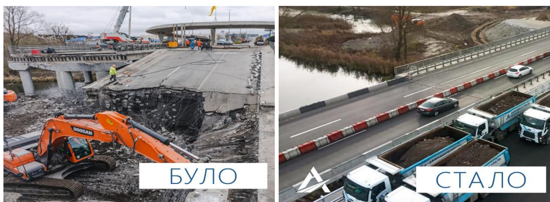
Рисунок 7 - Міст на дорозі М-06 Київ–Чоп у Стоянці
