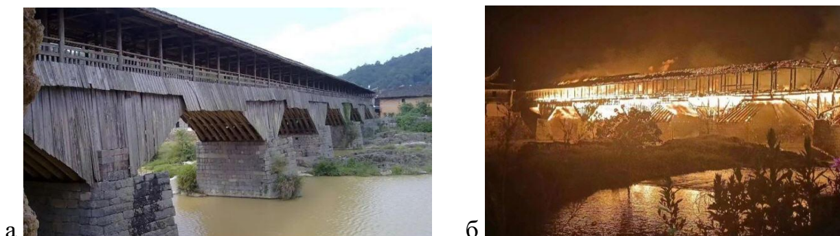
Рисунок 4 – Руйнування пожежею дерев'яного мосту Ваньань у Китаї: а – міст до пожежі; б – пожежа на мосту [2]
