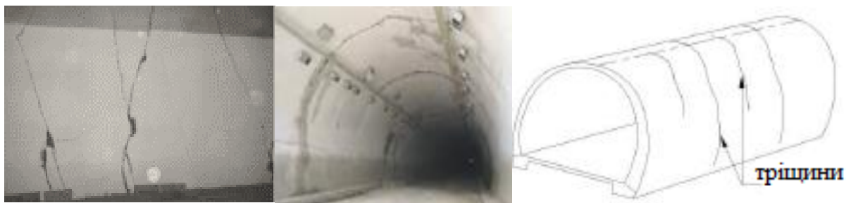
Рисунок 4 – Поперечні тріщини
