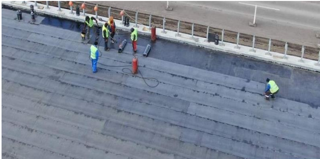
Рисунок 3 – Рулонно-мастична гідроізоляція
