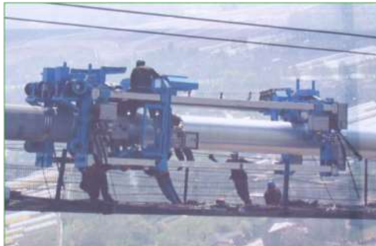
Рисунок 6 – Улаштування обмотки дротом несучих канатів
