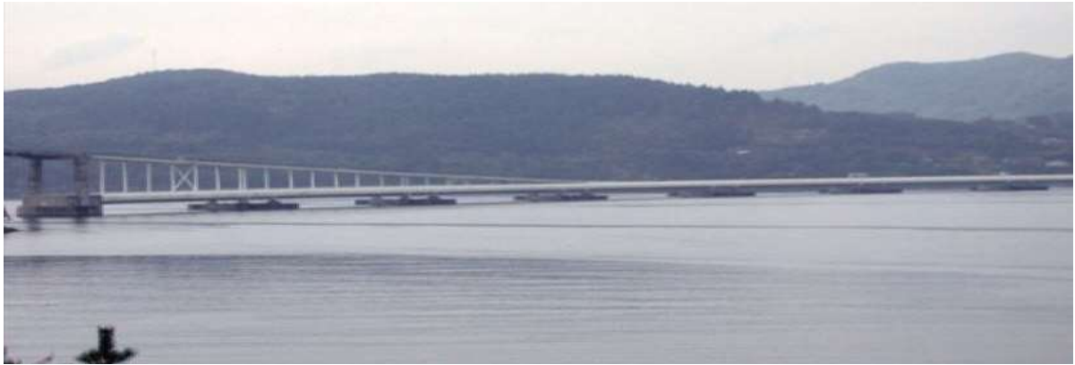
Рисунок 8.1 – Плавучий міст Нордхордланд у Норвегії [1]
