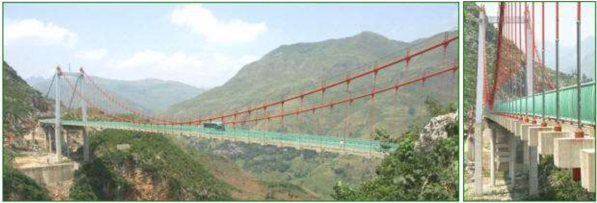
Рисунок 7 – Висячий міст із залізобетонною балкою жорсткості (Китай)
