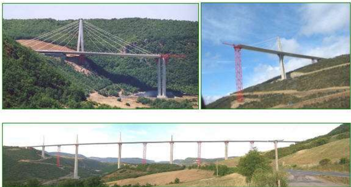
Рисунок 2 – Момент будівництва мосту Мійо
