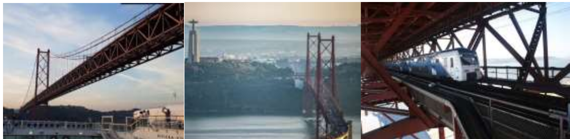
Рисунок 4 – Загальний вигляд мосту через річку Тахо (Португалія)
