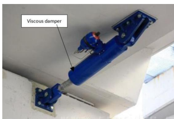
Рисунок 3 – Приклад встановлення в'язкого демпфера на мостовій опорі
