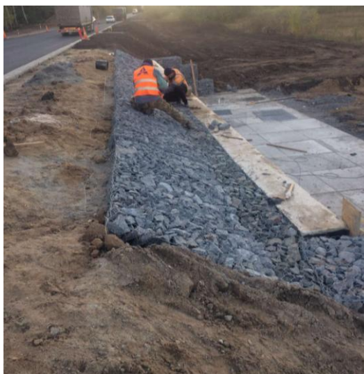
Рисунок 5 – Улаштування відкосних стінок у вигляді конструкцій з коробчатих габіонів
