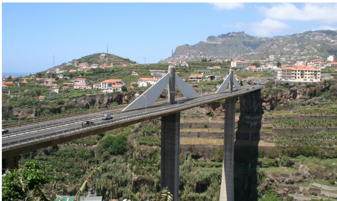
Рисунок 1 – Міст Понте дос Сокоррідос, побудований в 1993 році в Камара-де-Лобуш. Висота мосту 100 м, довжиною прольоту 106 м.
