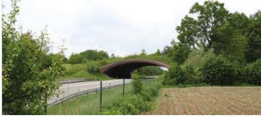
Рисунок 1 – Верхній біоперехід мостового типу (ландшафтний міст Weiherholz – дорога B31neu, Німеччина)
