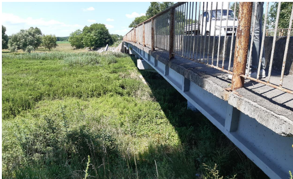
Рисунок 2 – Вид мосту від опори №1
