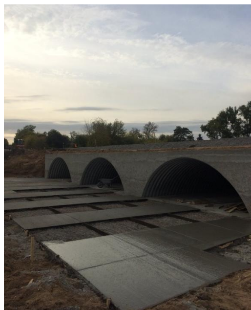
Рисунок 4 – Укріплення русла монолітним бетоном шаром 10 см
