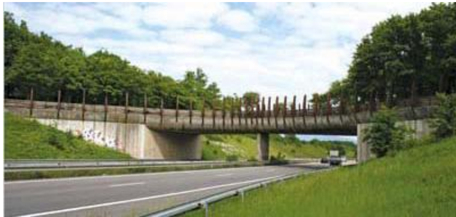
Рисунок 2 – Верхній біоперехід мостового типу (автострада A36, Франція)
