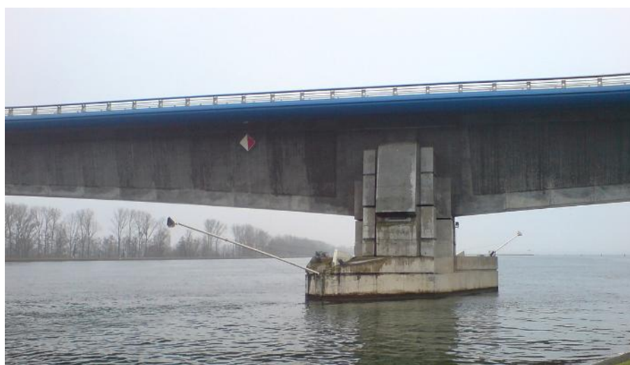
Рисунок 2 – Міст П'єр-Пфімлін, побудований в наприкінці 1990-х і на початку 2000-х років, довжиною 957 м, з головним прольотом 205 м. З'єднує Францію та Німеччину через річку Рейн.
