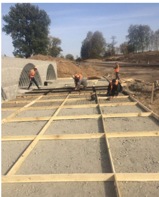
Рисунок 4 – Укріплення русла монолітним бетоном шаром 10 см
