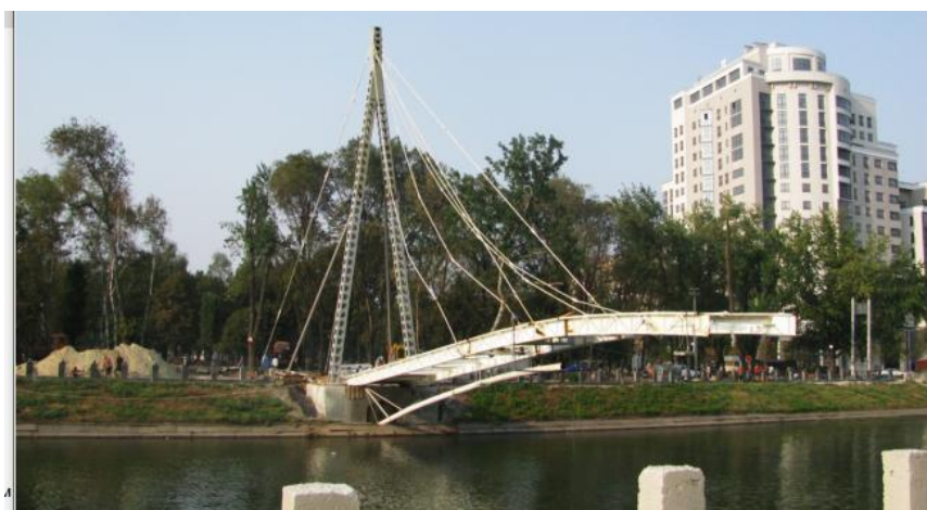
Рисунок 8 –Процес зведення пішохідного мосту (2010 р.)
