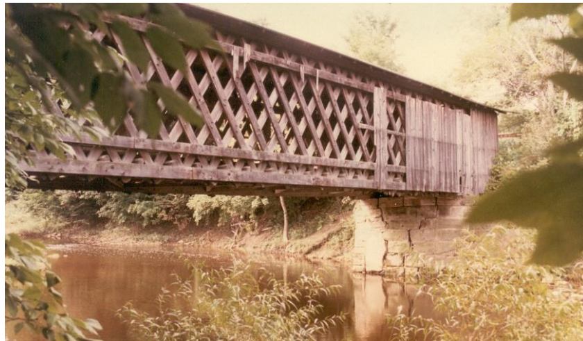
Рисунок 2 - Ґратчаста ферма на мості Рут Роуд, Огайо, 1849 р.
