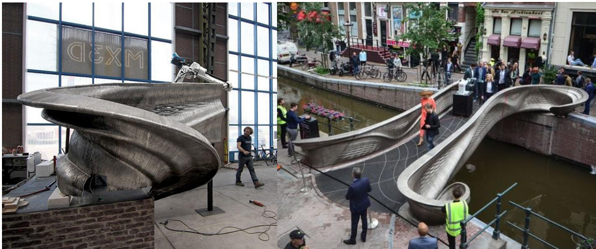
Рисунок 4 – Надрукований металевий міст в центрі Амстердама
