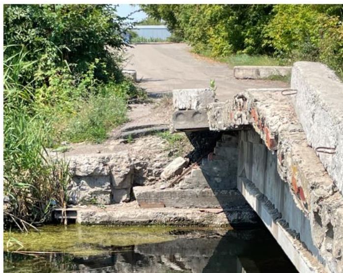
Рисунок 2 – Загальний вид берегової опори
