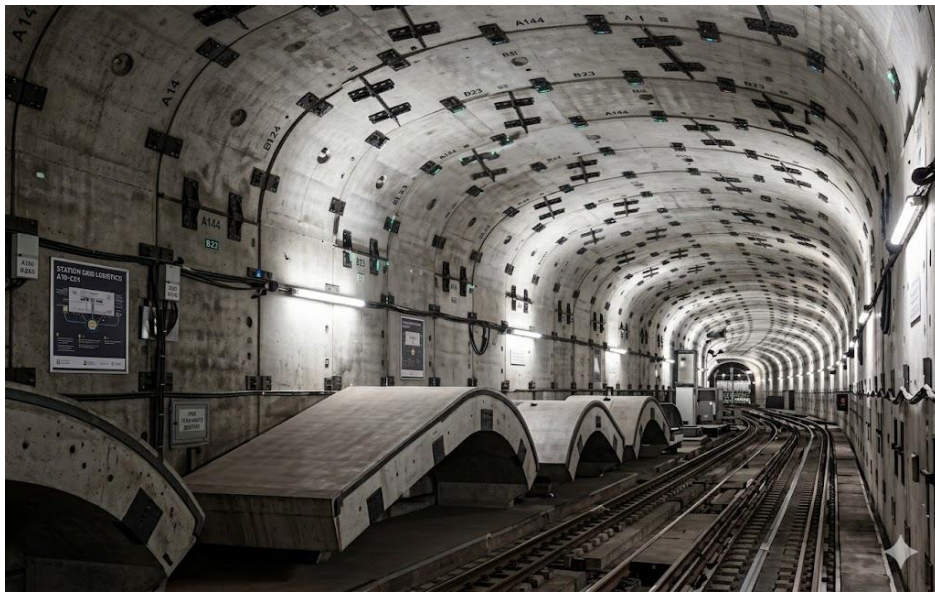
Рисунок 5 – Верхній відсік тунелю з оправою вертикально-овального перерізу з прямими гранями
