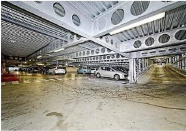
Рисунок 2 – Пропуск комунікацій через композитне перекриття з перфорованими балками
