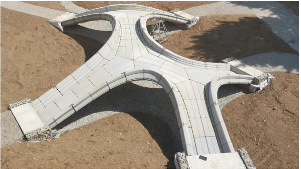
Рисунок 3 – Монтаж 3D-друкованого мосту із збірних елементів (реальний об'єкт)
