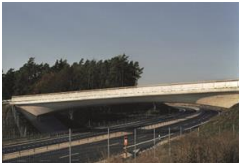
Рисунок 7 – Інтегральний опорний міст з похилими опорами
