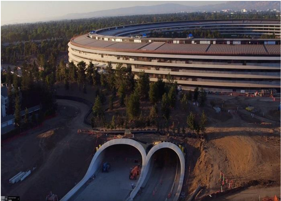
Рисунок 3 – Підземний паркінг в комплексі ApplePark
