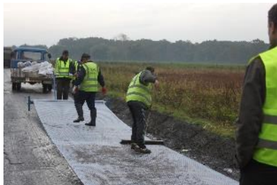
2. Укладання GlasGrid CG
