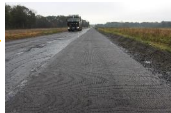
4. Процес висушування сполучної емульсії
