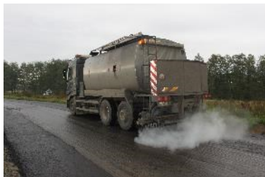
1. Нанесення сполучної емульсії •Рівномірно, 0,9 або 2,0 кг/м 2
