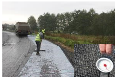
3. Додатковий притиск щіткою •Після висихання тест міцності приклеювання (9 кг на відрив)
