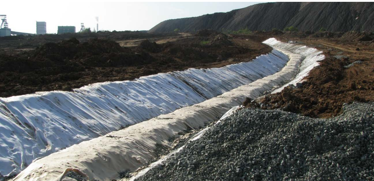
Основание полигона солеотвала Polyfelt TS 30-80
