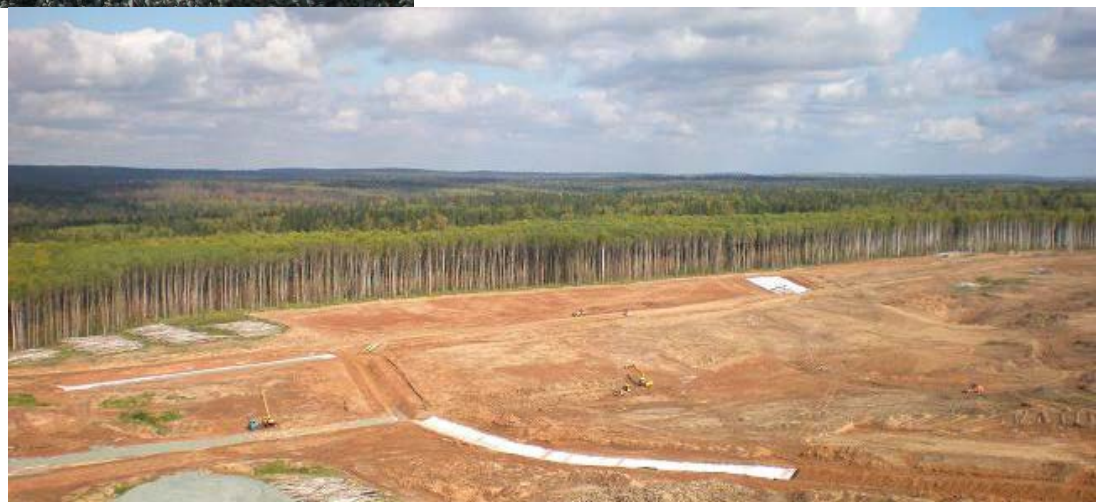
Основание полигона солеотвала Polyfelt TS 30-80
