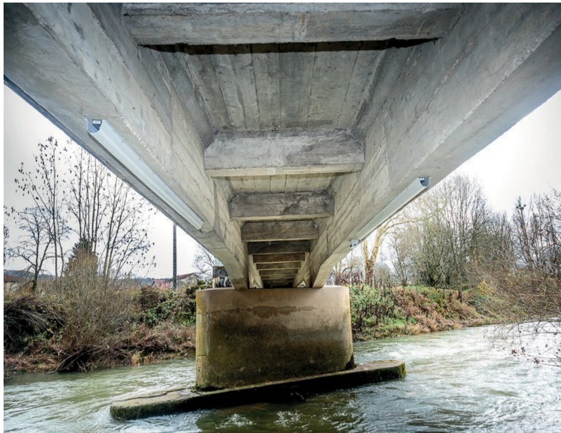
Pont de Noblens, Département de l'Ain, FRANCE
