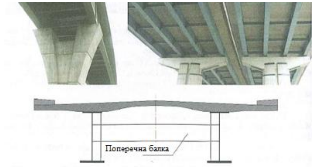
Рисунок 2 – Двотаврові балки об'єднані поперечними балками в середньому рівні
