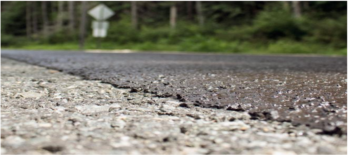
Рисунок 1 – Шар зносу відновлений способом мікросерфейсінг
