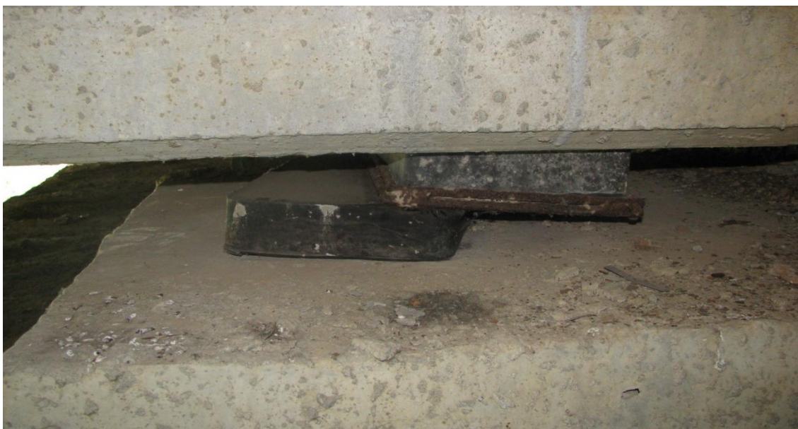
Рисунок 1– Зсув верхньої частини гумової опорної частини вздовж балки
