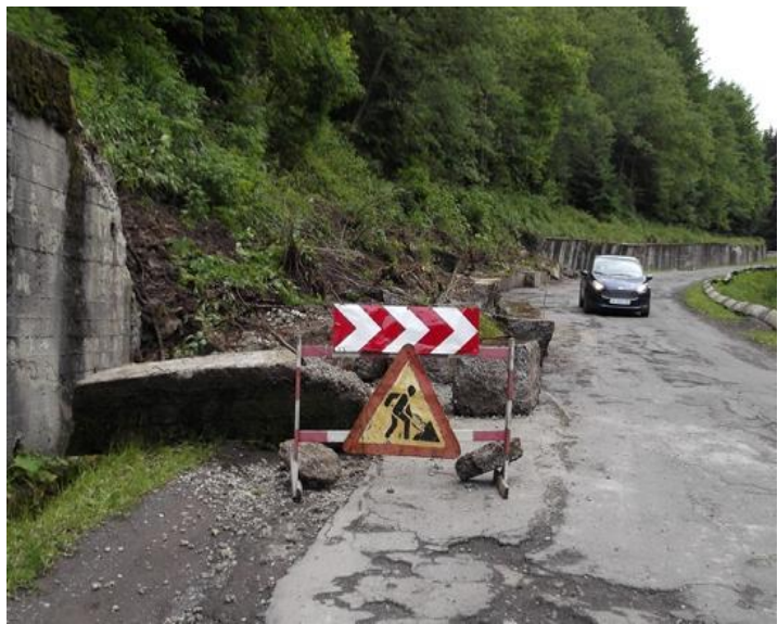
Рисунок 1.3 – Руйнування підпірної стінки на перевальній ділянці автомобільної дороги Міжгір'я -Колочава-Буштино (Синевирський перевал)
