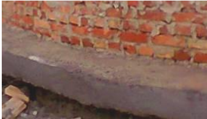
Рис. 5. Основа купола після підсилення [1]
