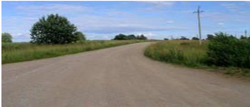
Рисунок 2 – Отримана міцна ґрунтова дорога
