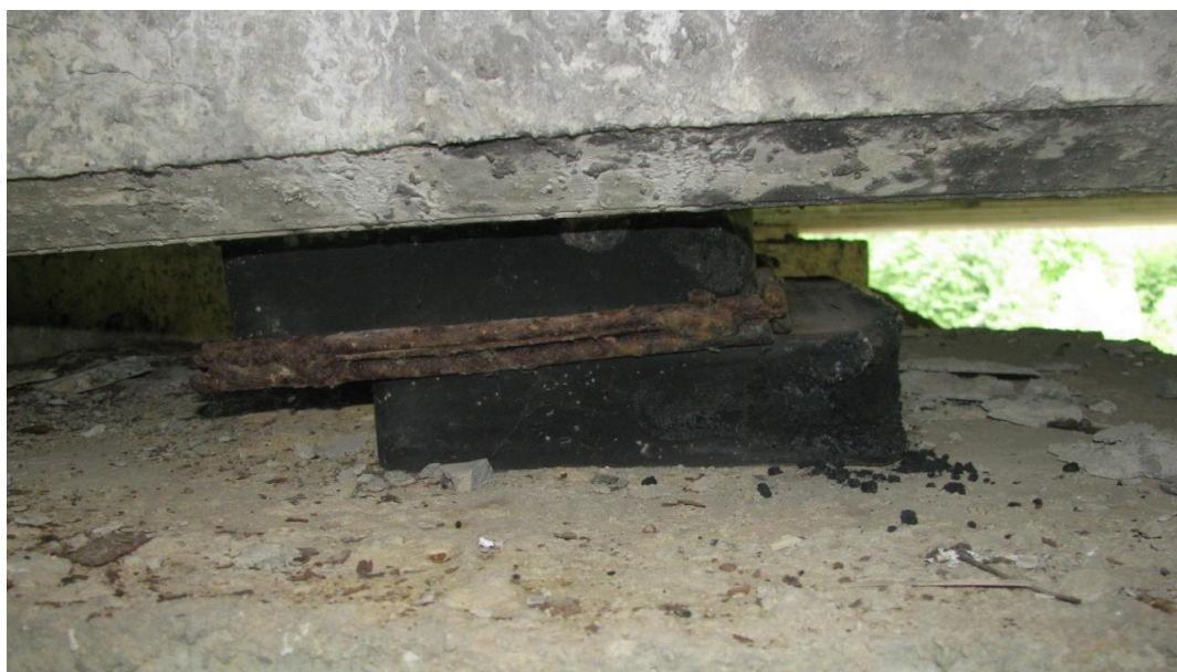
Рисунок 2 – Зсув нижньої частини гумової опорної частини вздовж балки
