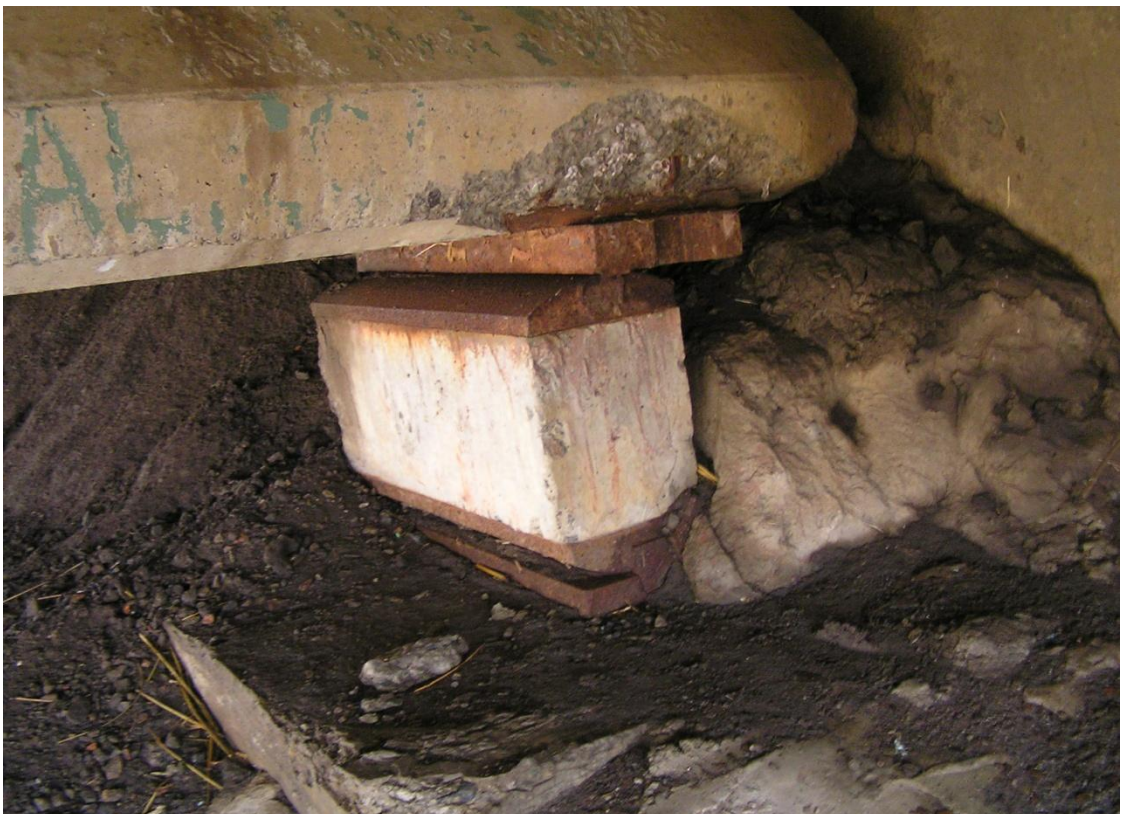
Рисунок 5 – Зсув балки відносно опорної частини і як наслідок її руйнування
