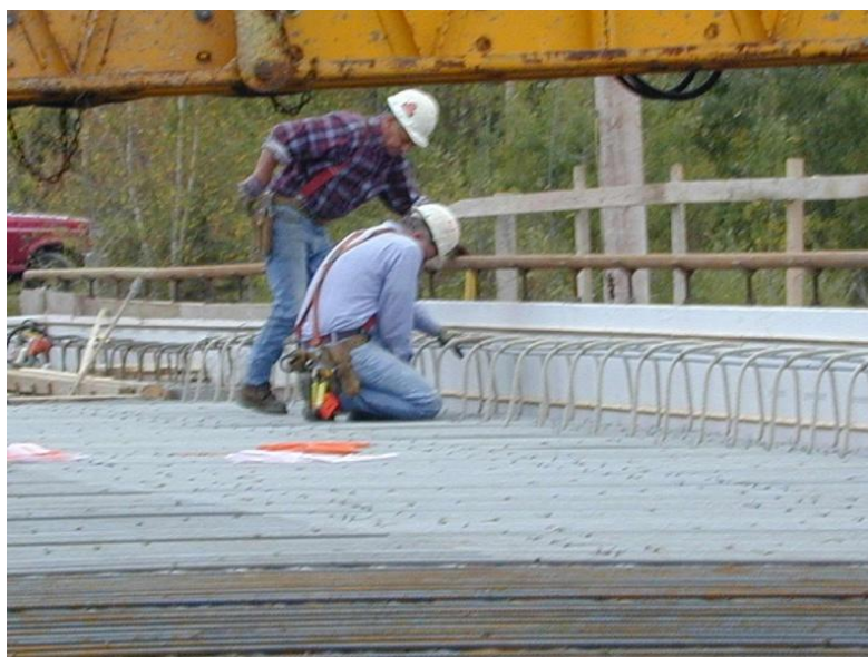
Рисунок 1 - Монтаж вигнутих стержнів з композитного армованого пластику
