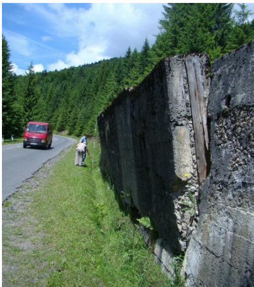
Рисунок 1.3 – Руйнування підпірної стінки на перевальній ділянці автомобільної дороги Міжгір'я -Колочава-Буштино (Синевирський перевал)
