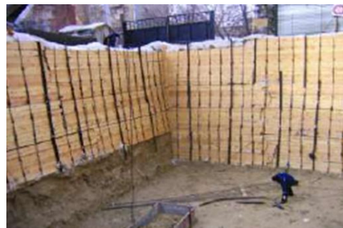
Рисунок 1.3 – Загальна схема горизонтального армування при будівництві котлованів
