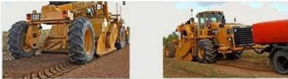
Рисунок 1 – Введення в'язучого у ґрунт за допомогою ресайклера
