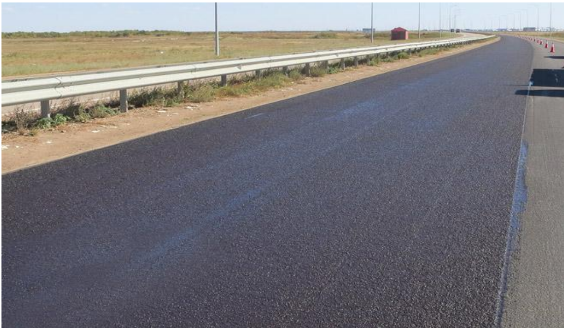
Рисунок 2 – Закінчений шар зносу на швидкісній трасі
