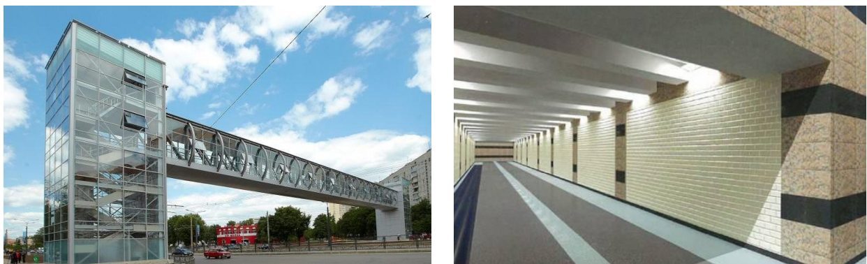
Рисунок 1 – Загальний вид пішохідного мосту і тунелю
