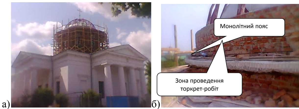
Рис. 3. Реконструкція Свято-Покровського собору в м. Чугуєві: а – конструкція куполу; б – місце підсилення монолітного поясу
