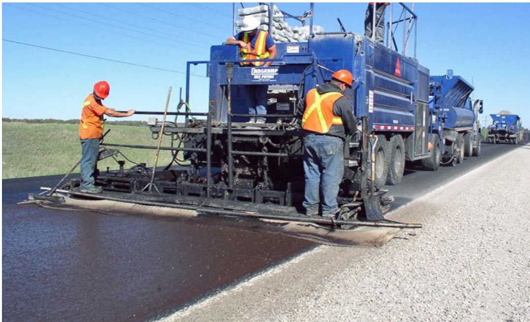
Рисунок 3 – Процес мікросерфейсінгу
