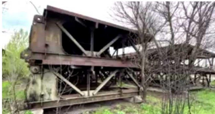
Рисунок 3 - Стан комплекту САРМ, що зберігався на складі
