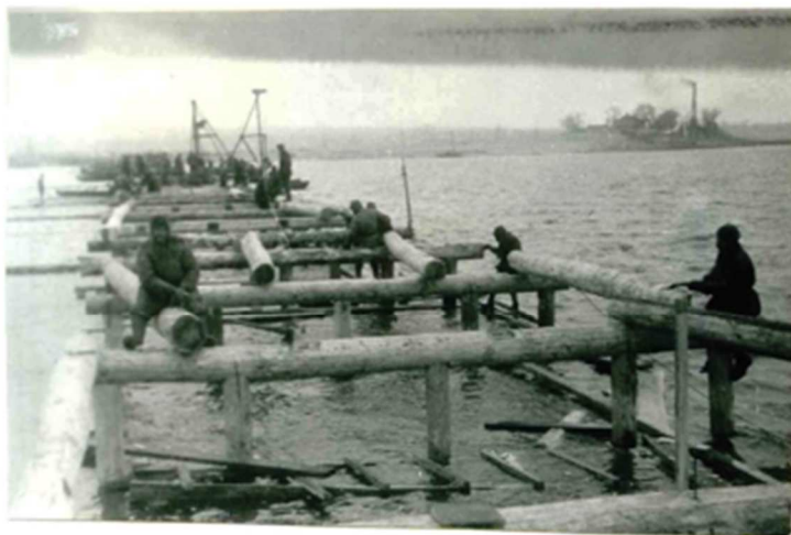
Будівництво берегових прольотів мосту біля м. Запоріжжя
