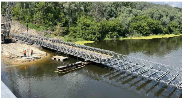
Рисунок 7 - Збірно-розбірний міст Bailey Bridge, який влаштовано у
