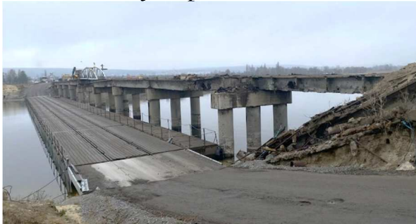
Рисунок 11 - Понтонний міст, що влаштовано у Харківській області
