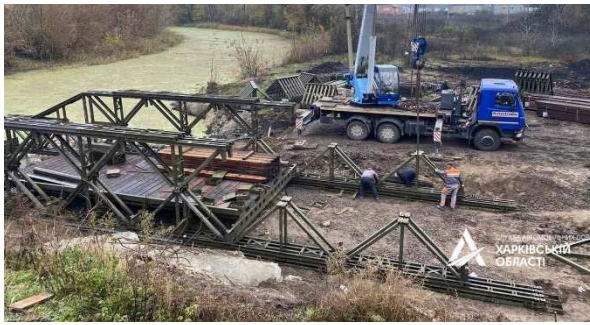
Рисунок 10 - Чеський міст TMS (Těžka mostova souprava), який встановлено у Харківській області
