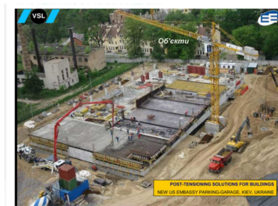
Рисунок 1 – Будівля гаража Посольства США в Києві
