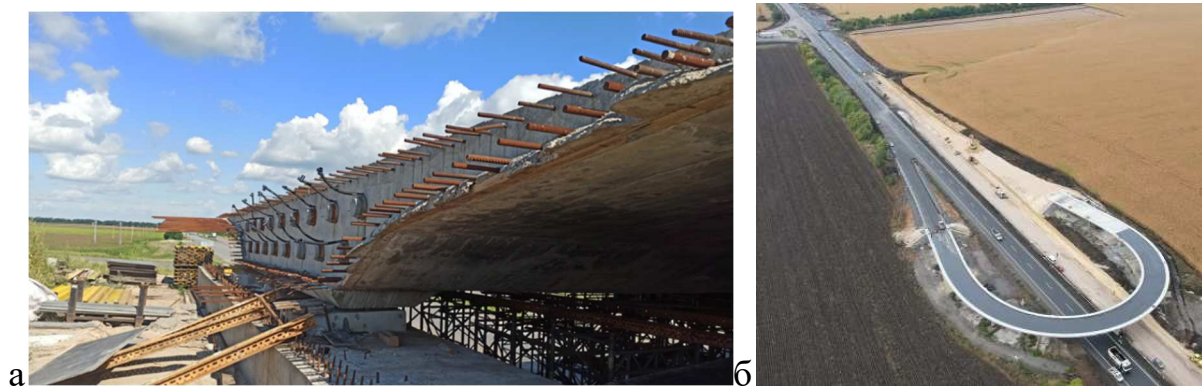
Рисунок 2 – Шляхопровід (а) та естакада-підкова (б) Полтавська область
