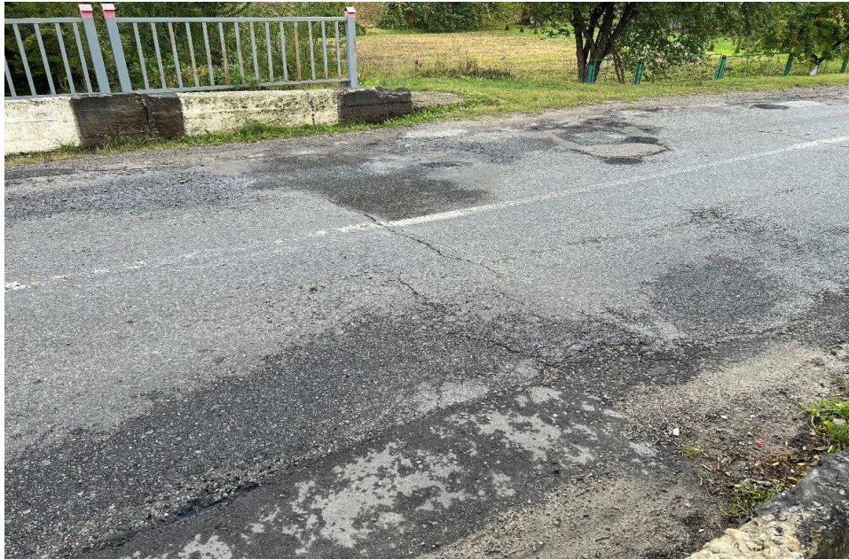
Рисунок 3 – Ділянка сполучення малого мосту з насипом. Латки, тріщини в покритті, локальні просідання основи
