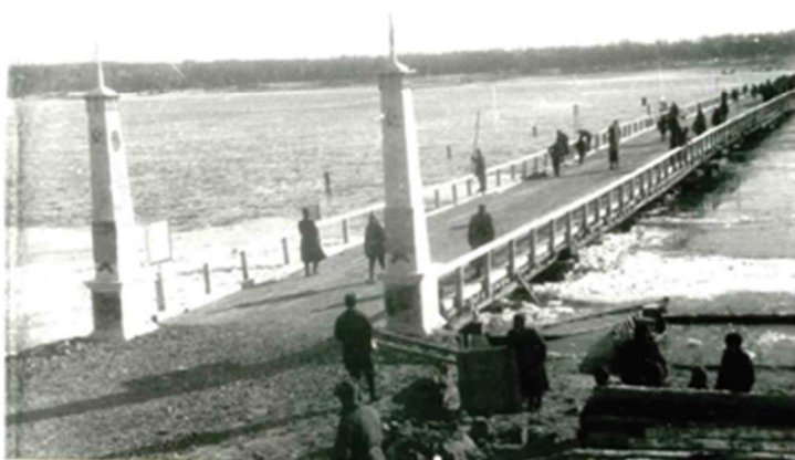
Збудований міст через р. Новий Дніп у м. Запоріжжя
