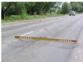
Рис. 1. Коля на асфальтобетонному покритті
