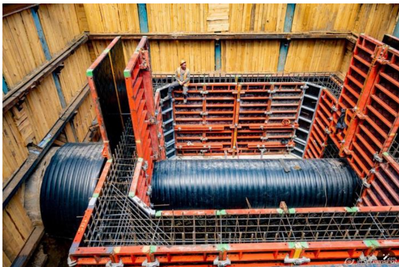
Рис.2. Реконструкція каналізаційного колектору, Харків [5]
