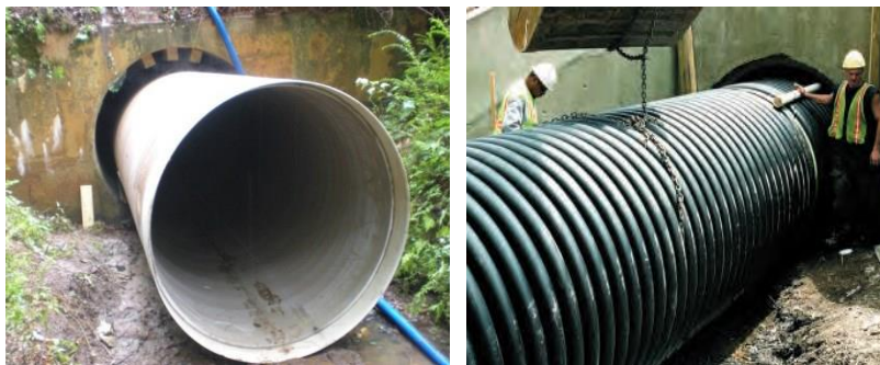
Рис. 1. Ремонт методом «гільзування» залізобетонної труби
