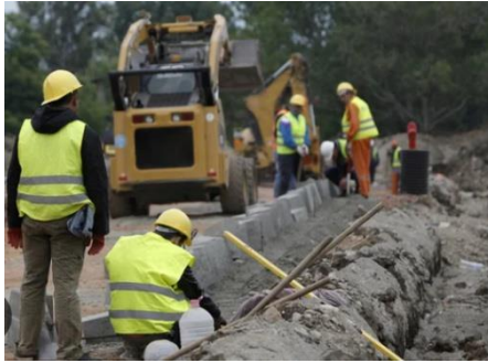
Рисунок 2 – Реконструкція дорожнього полотна
