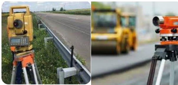
Рисунок 1.1 – Геодезичні прилади для проведення знімання автодороги
