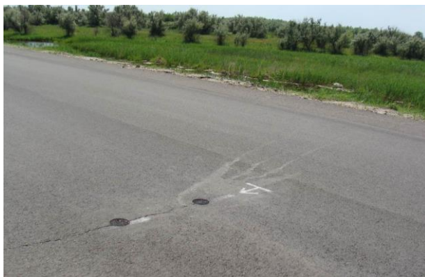
Рисунок 3 – Загальний вигляд ділянки
