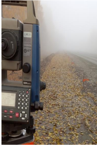
Рис. 1 – Контроль встановлення струни електронним тахеометром
