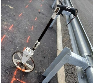
Рис. 5 – Визначення місцезнаходження дорожніх знаків за допомогою курвіметру
