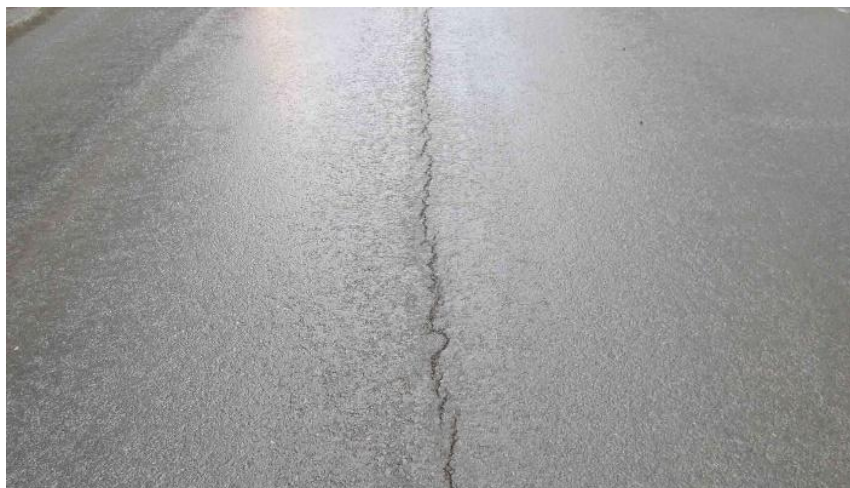
Рисунок 1 – Поздовжня тріщина
