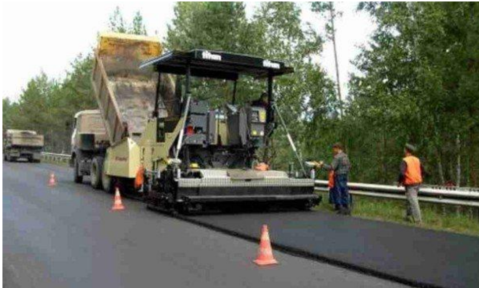
Рисунок 2 – Влаштування покриття одним асфальтоукладачем
