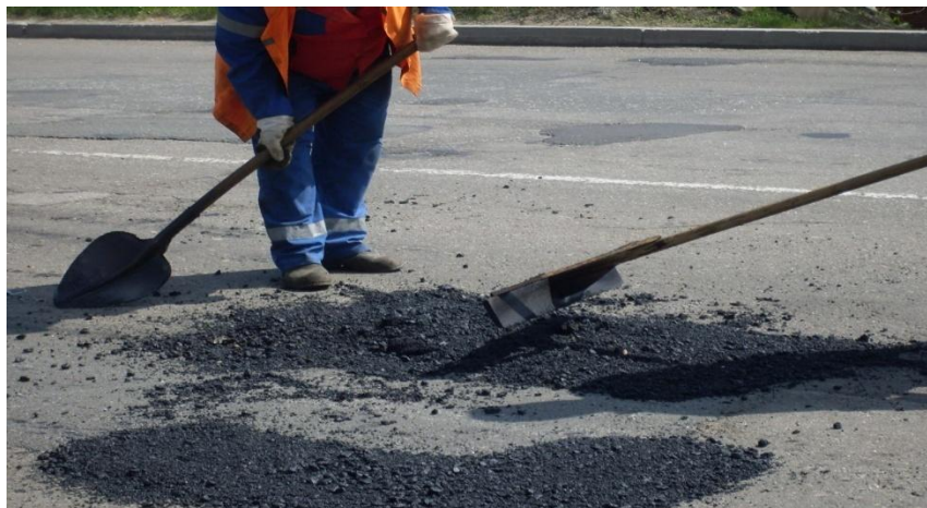
Рисунок 1 – Ямковий ремонт гарячою асфальтобетонною сумішшю
