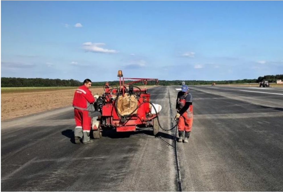
Рисунок 4 – Заповнення шва мастикою з використанням заливника швів
