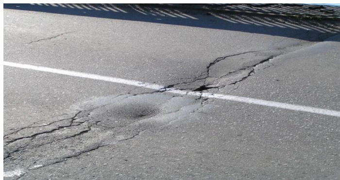
Рисунок 3 – Руйнування шарів дорожнього одягу в зоні деформаційного шву на сполученні з перехідною плитою (міст через р. Сів. Донець в сел. Ст. Салтів)
