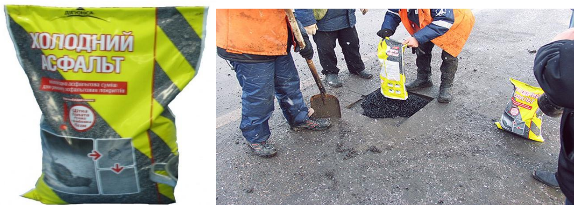
Рисуюнок 2 – Ямковий ремонт холодною асфальтобетонною сумішшю
