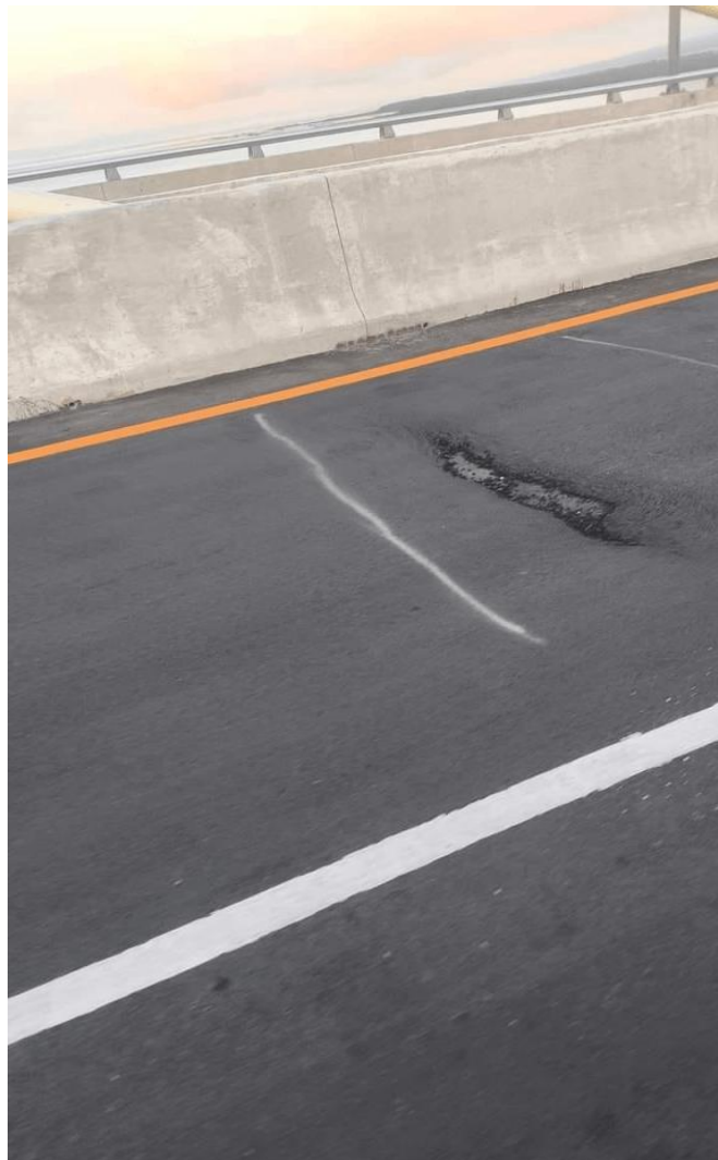
Рисунок 2 – Місцева просадка насипу біля одного з мостів через затоку Пангіл (Panguil Bay Bridge, Tangub City, Misamis Occidental, Tubod, Lanao del Norte) Філіппіни
