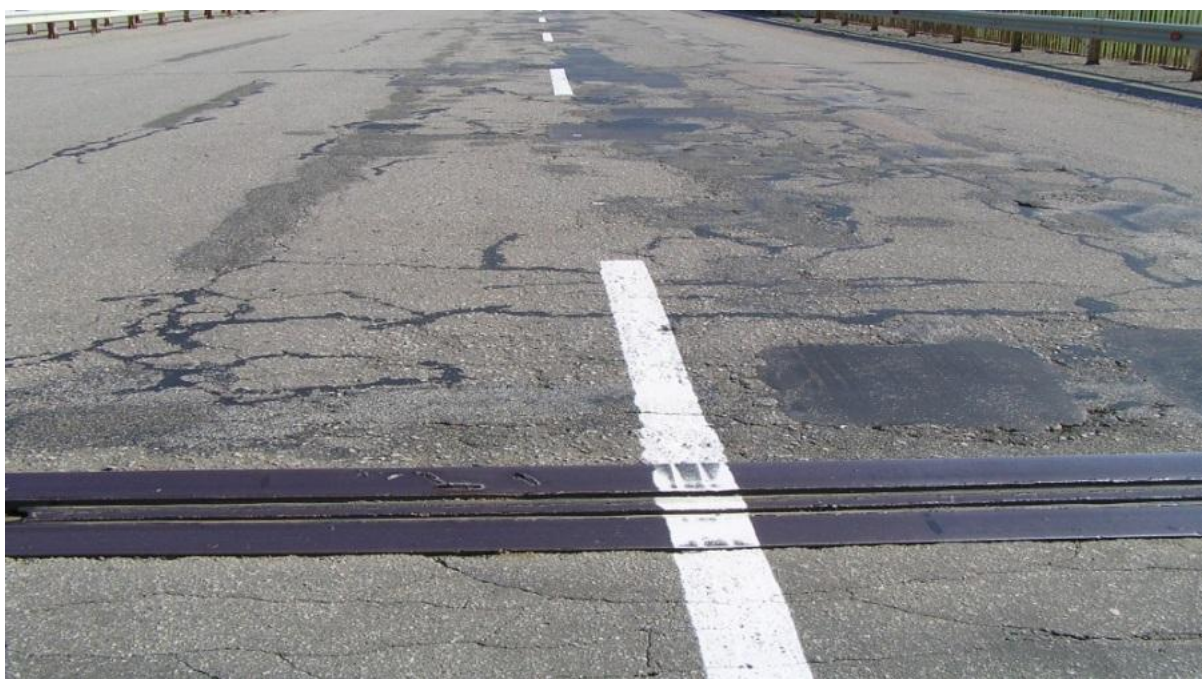
Рисунок 1 – Наявність локальних руйнувань шарів дорожнього одягу вздовж деформаційного шву на шляхопроводі на автомобільній дорозі М 29 Харків-Красноград-Перещепіно (Люботин-Мерефа) в селищі Люботин
