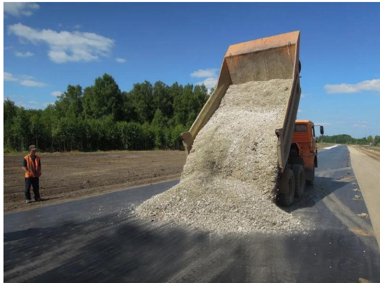
Рисунок 1 – Влаштування шару основи з щебенево-піщаної суміші
