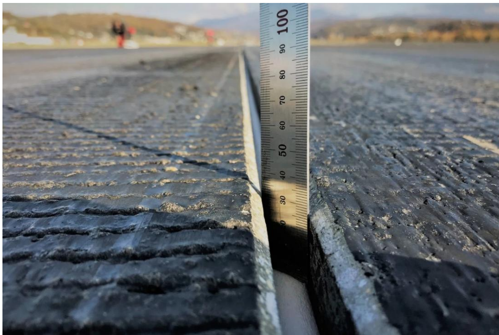
Рисунок 3 – Укладання шнура.
