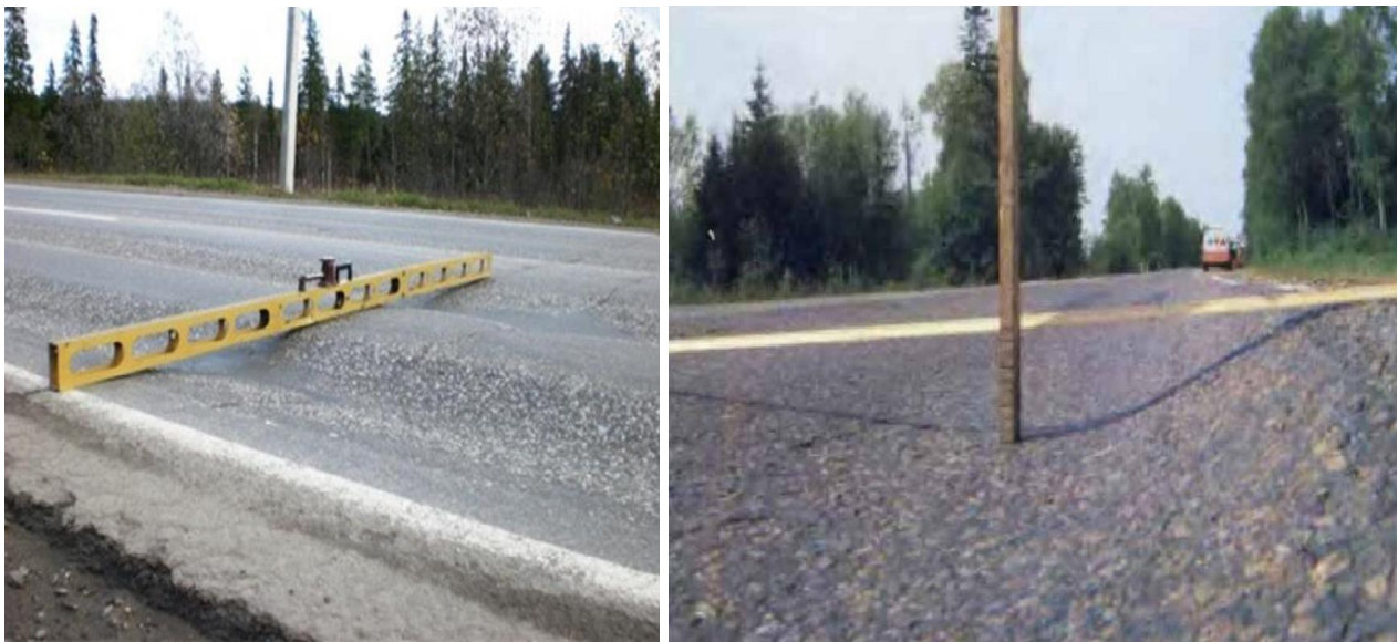
Рисунок 5 – Колійність на дорожньому покритті
