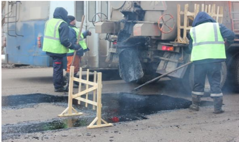
Рисунок 3 – Ямковий ремонт литим асфальтобетоном
