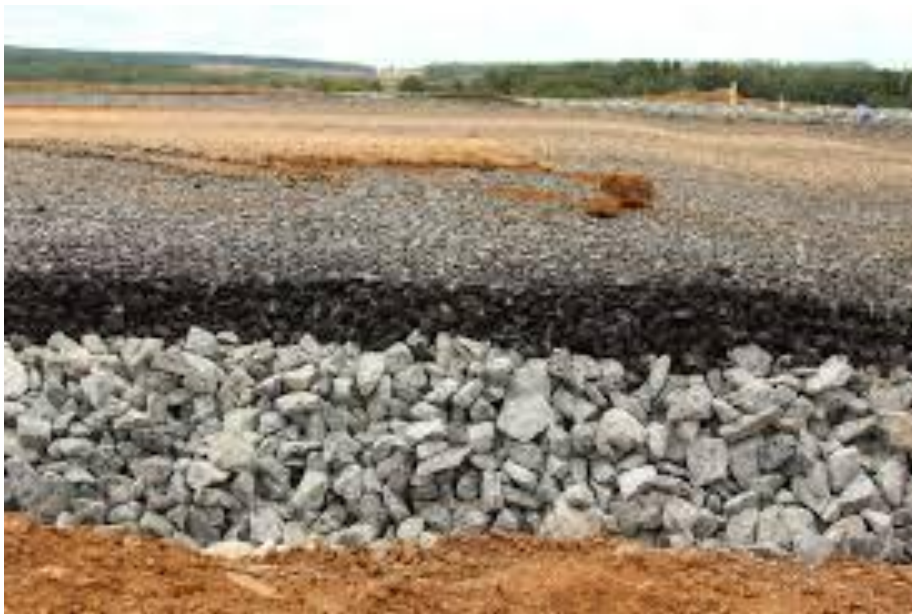
Рисунок 1 – Щебеновий шар дорожнього одягу
