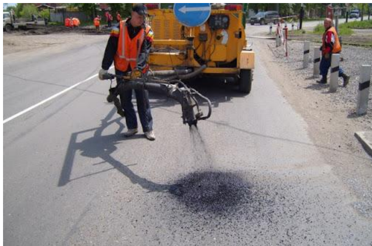
Рисунок 4 – Ямковий ремонт струменево-ін'єкційним методом
