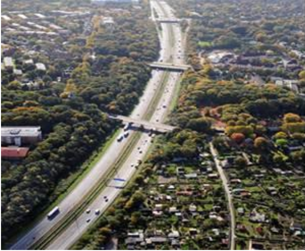
вигляд траси А7 до реконструкції реконструкції
