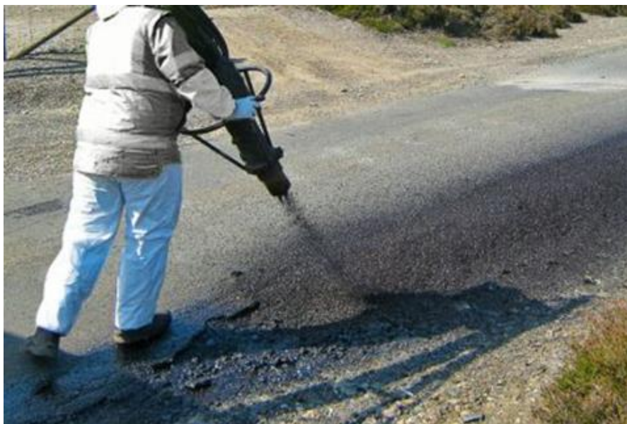
Рисунок 3 - Струменево-ін'єкційна холодна технологія ремонту
