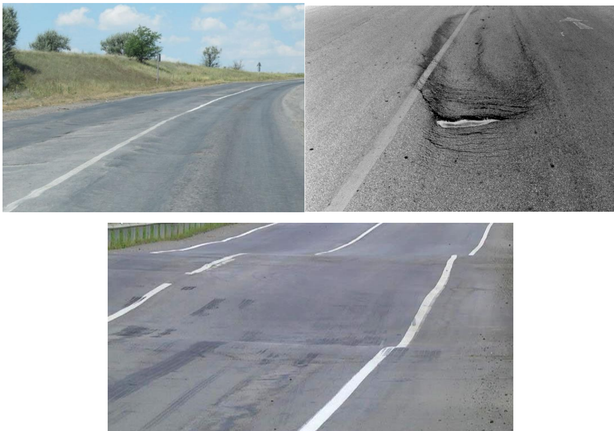
Рисунок 1 – Деформації асфальтобетонного покриття
