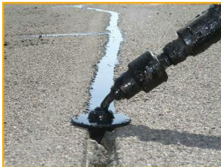
Рисунок 2 – Ремонт тріщин мастикою
