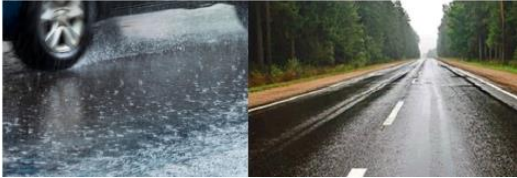
Рисунок 3 – Ділянки доріг в водонасиченому стані
