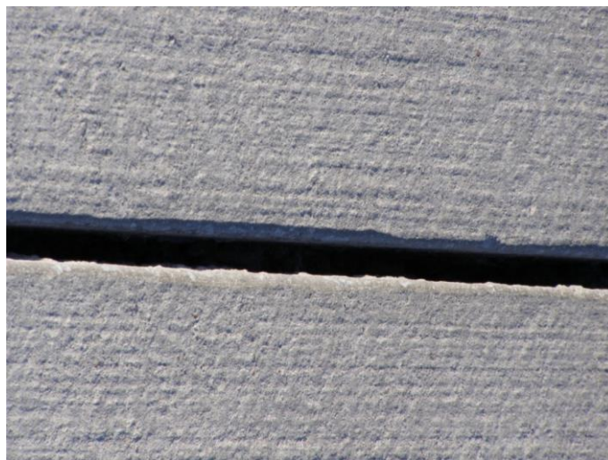
Рисунок 6 – Приклад не загерметизованих деформаційних швів
