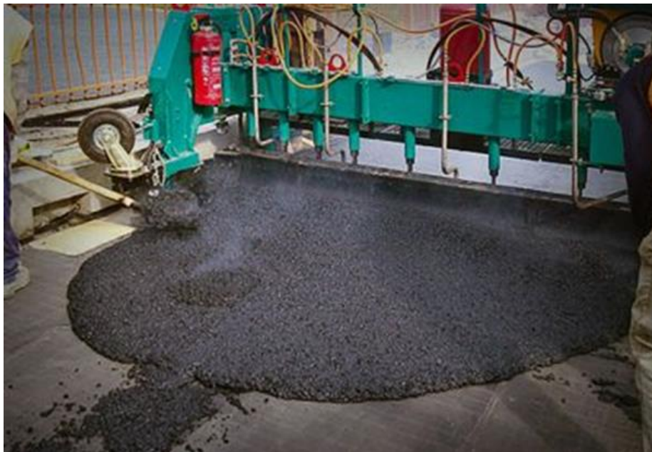
Рисунок 2 – Розподіл асфальтобетонної суміші
