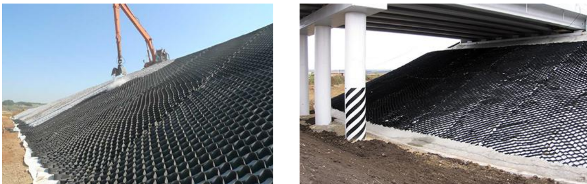
Рисунок 1 – Укріплення укосів та конусів шляхопроводів георешіткою
