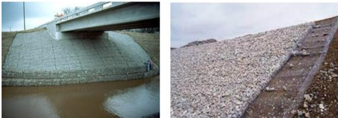
Рисунок 4 – Укріплення укосів насипів та конусу мостів матрацами Рено
