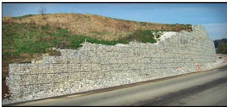
Рисунок 3 – Укріплення природніх укосів габіонами
