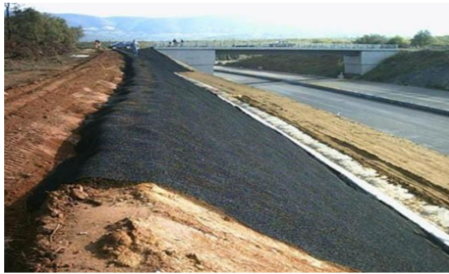
Рисунок 2 – Укріплення укосів геоматами
