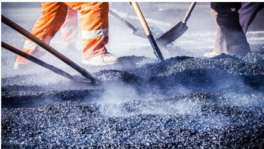
Рисунок 1 – Укладання гарячої асфальтобетонної суміші
