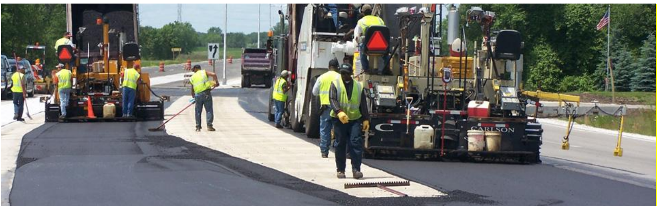
Рисунок 2 – Укладання теплої асфальтобетонної суміші
