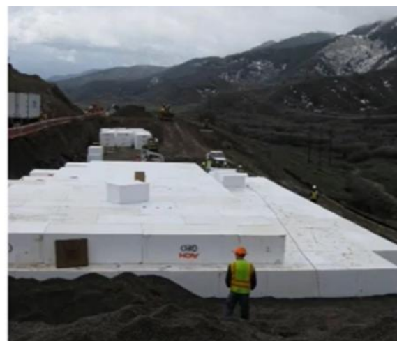
Рисунок 4 – Відновлення насипу на слабких основах автомобільної дороги SH-13, США
