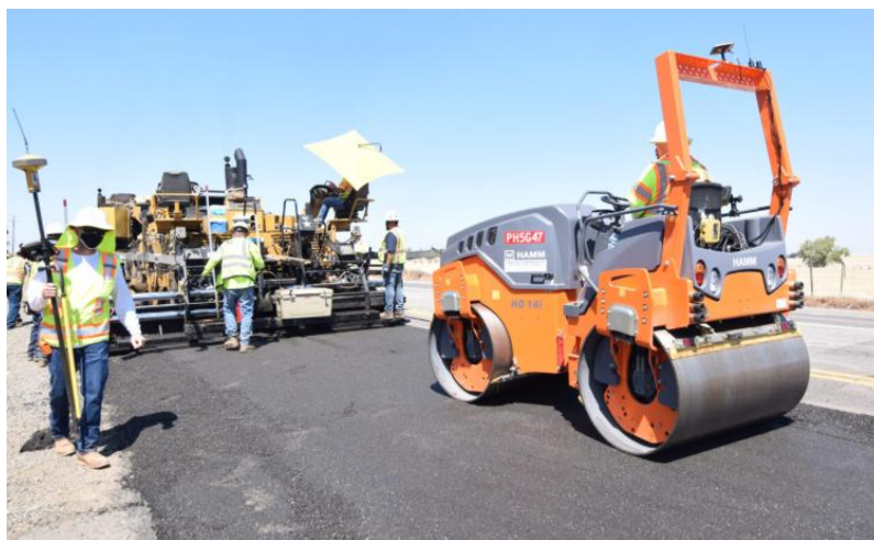
Рисунок 2 – Ділянка дороги у Каліфорнії покрита переробленим пластиком
