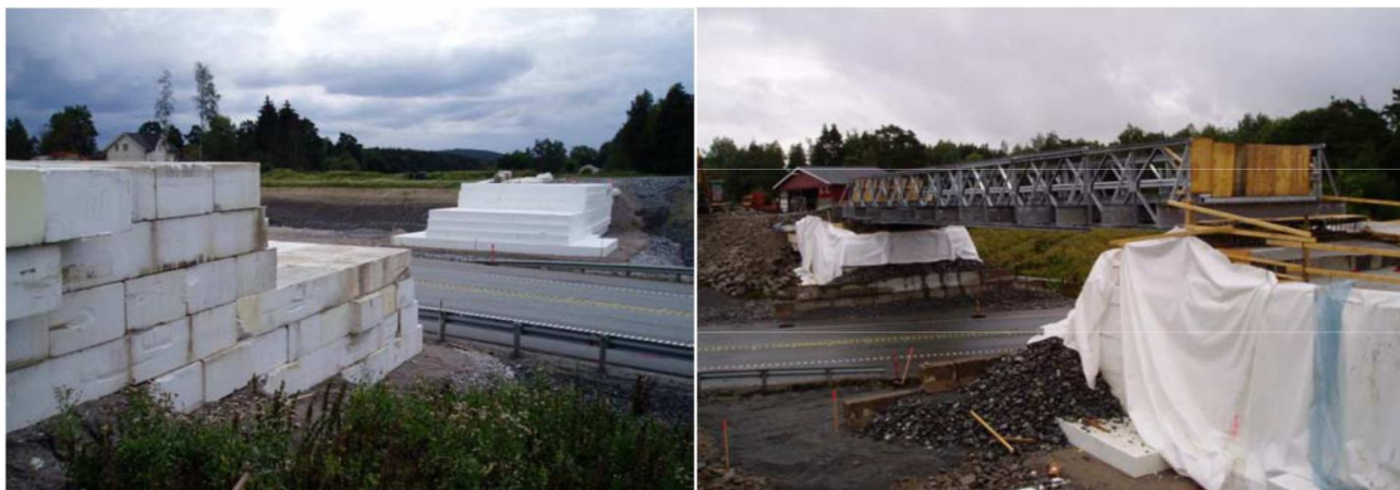
Рис. 2. Влаштування крайніх опор мосту Grimsøyvegen безпосередньо на масиві з EPS-геопіни
